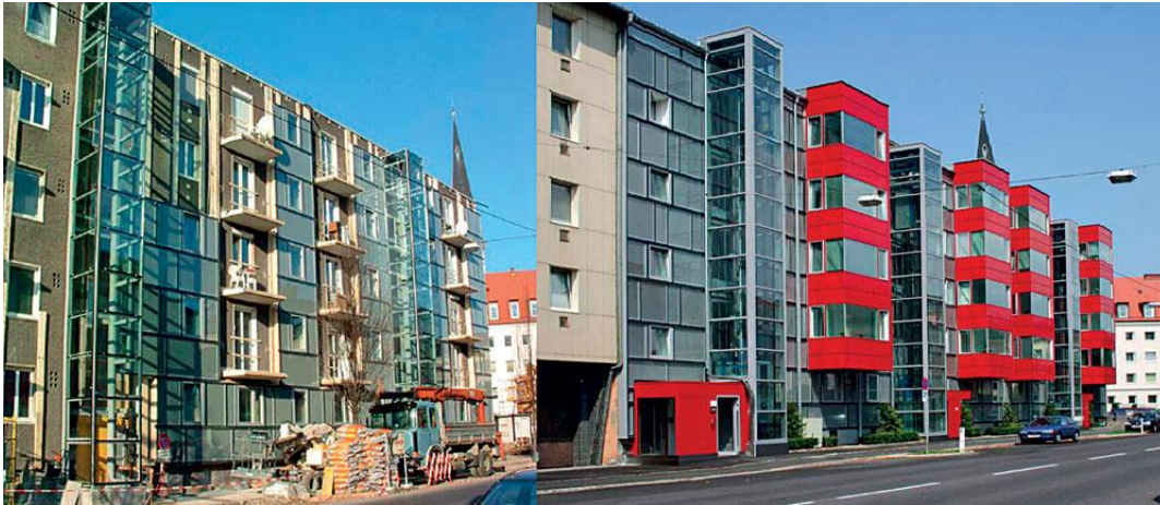
Obr. 2 Obnova bytového domu v Linzi – použité prefabrikované fasádne panely, dosiahnutá úspora energie 90 %
