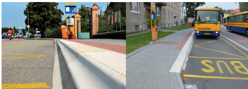
Obr.2.5.5 Bezbariérové zastávky MHD - detail Kasselský obrubník; Zdroj: 5
