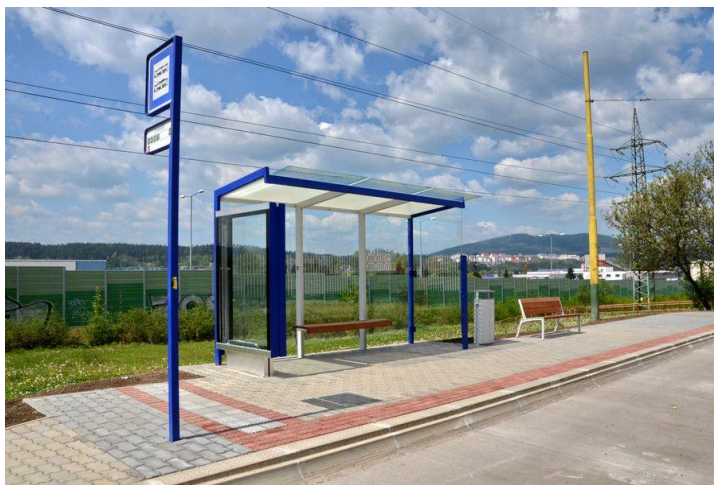
Obr. 2.5.6 Príklad novorekonštruovanej zastávky MHD v Žiline s aplikáciou debarierizačných opatrení a príslušnej výbavy; Zdroj: dpmz.sk
