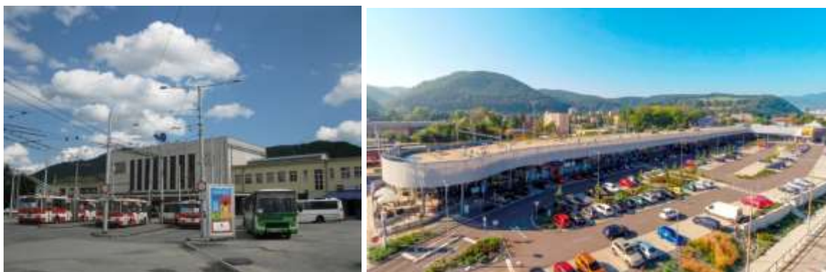
Obr. 5.6.8 Priestory pred železničnou stanicou a autobusovou stanicou v meste Banská Bystrica
