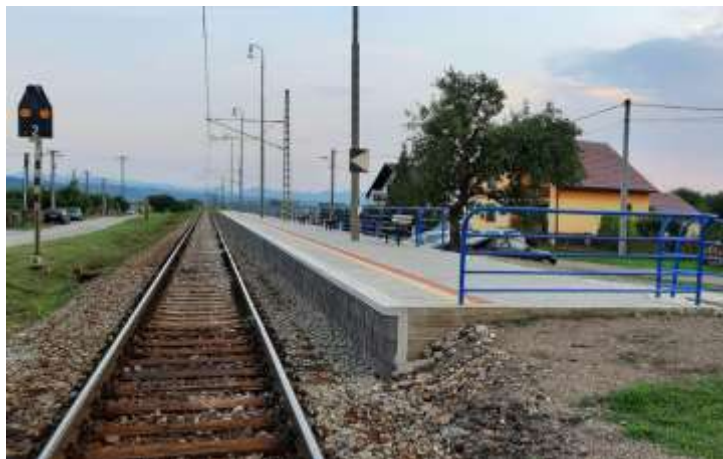
Obr. 5.6.4 Komplexná rekonštrukcia železničnej zastávky Hronsek
