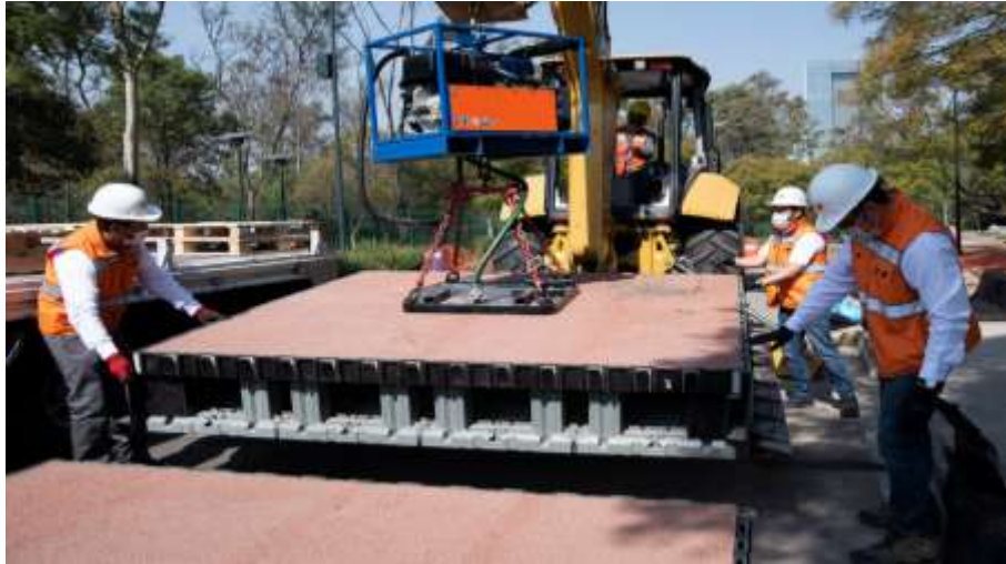
Obr. 5.4.17 Používanie prefabrikátov s uložením šachty pre zber vody pre cyklotrasu
