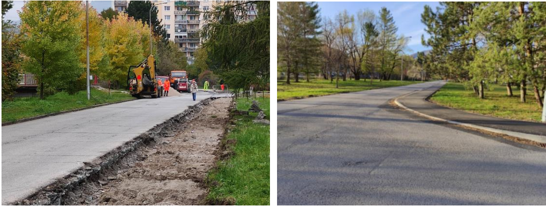
Obr. 1.15.11 Rekonštrukcia chodníka na ul. Severná, vľavo (jeseň 2021), vpravo po rekonštrukcii
