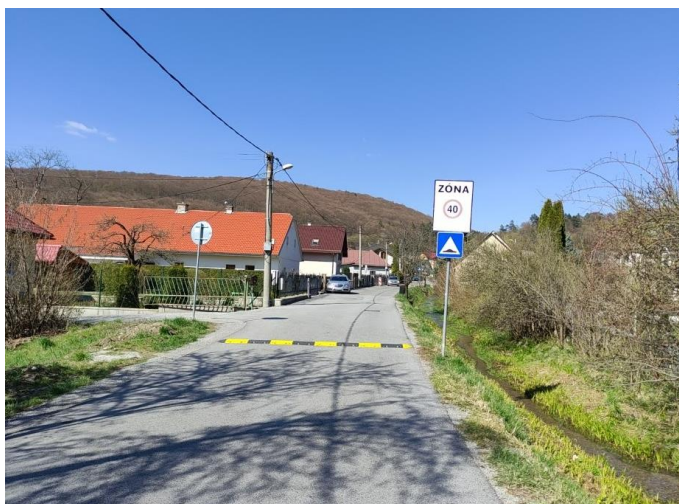
Obr. 1.15.5 Vstup do zóny 40
