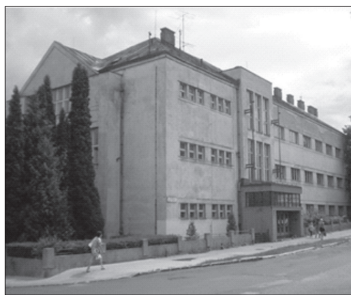
Bývalá Spojová priemyselná škola Jozefa Murgaša
