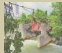
Regulátor vody na potoku Bystrica
