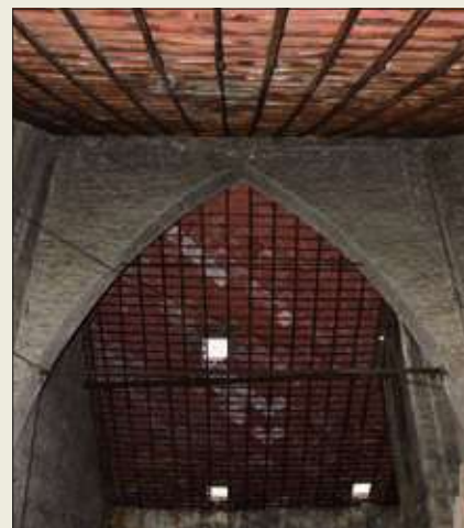
Unikátna zavesená reťazová strecha v dome č. 7
