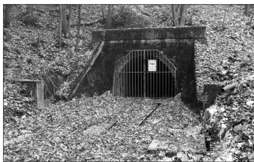
Ústie prekopového tunala zo strany Španej Doliny
