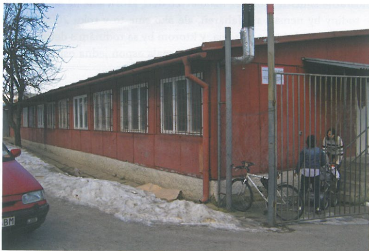
Zariadenie núdzového bývania KOTVA IV. – útulok, kapacita 28 lôžok.
