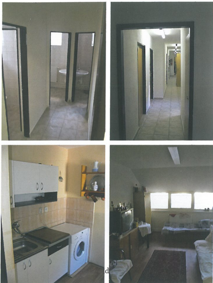
Po rekonštrukcii Nádej - Šanca, r. 2006
