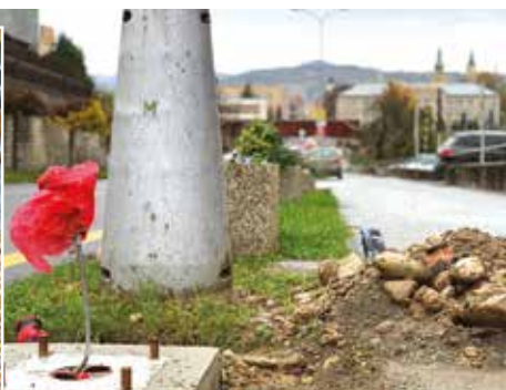
Nové pätky pre osadenie stožiarov
