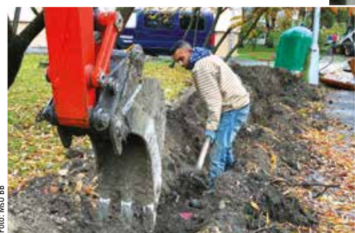
Práce na Uhlisku sú v plnom prúde
