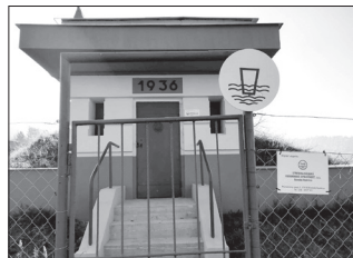
Vodojem v obci Strelníky.
