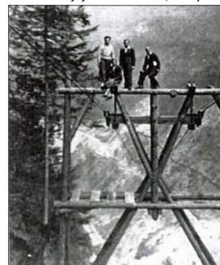
Stavba trate bola veľmi náročná
