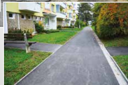
Slnecná ulica pred a po oprave
