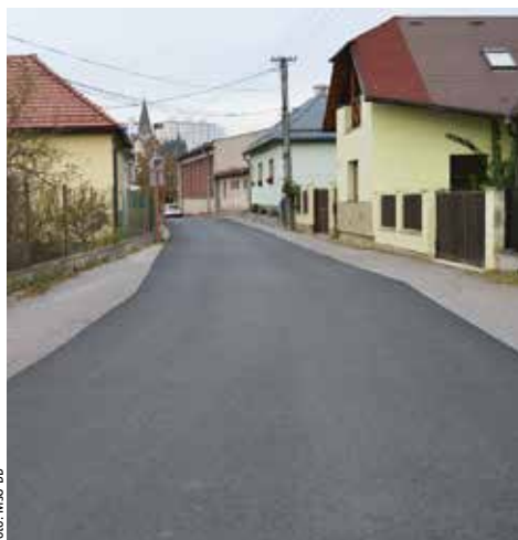
Nová vozovka na ulici Na Zábave
