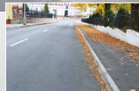
Komenského ulica pred a po oprave
