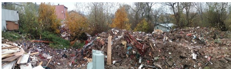
Obr. 51 Odstraňovanie nelegálnej skládky, Na Hrbe
