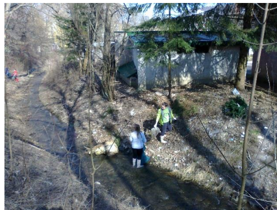
Obr. 59 Čistenie vodného toku, potok Udurná, zdroj SVP š.p.
