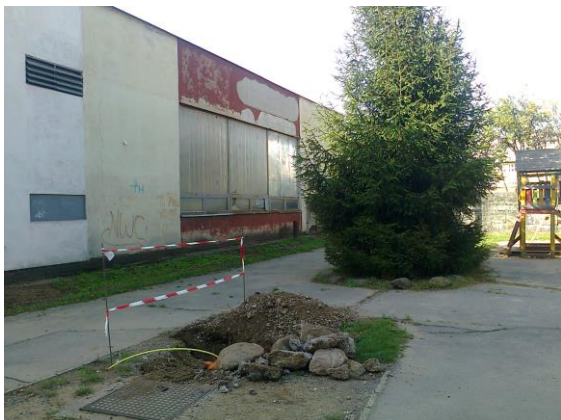
Obr. 33 Rozkopávka na ul. Radvanská, zdroj mesto Banská Bystrica
