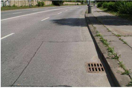
Uličný vpust pôvodný (pre prevádzku cyklistov nevhodné prevedenie - vľavo) a po otočení vhodné - vpravo (Foto: Ing. Květoslav Syrový - Praha Letňany)
