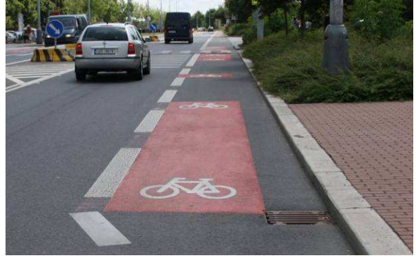
Uličný vpust pôvodný (pre prevádzku cyklistov nevhodné prevedenie - vľavo) a po otočení vhodné - vpravo (Foto: Ing. Květoslav Syrový - Praha Letňany)
