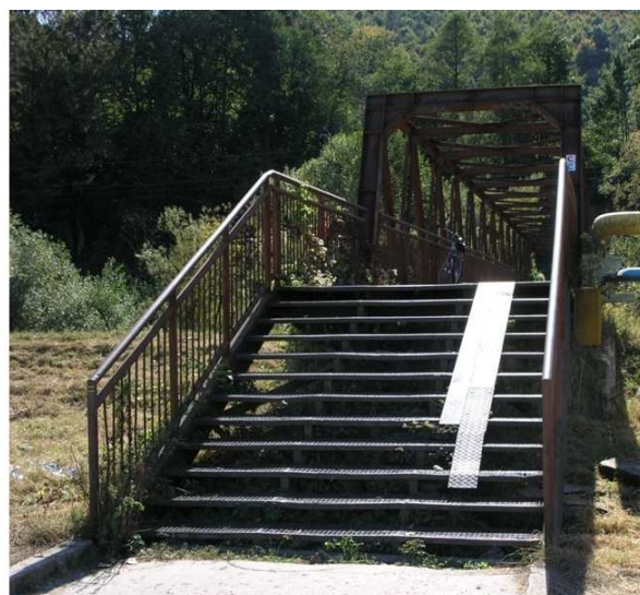
Lávka cez Hron v Majeri – neúplné lyžiny bez proti-šmykovej úpravy
