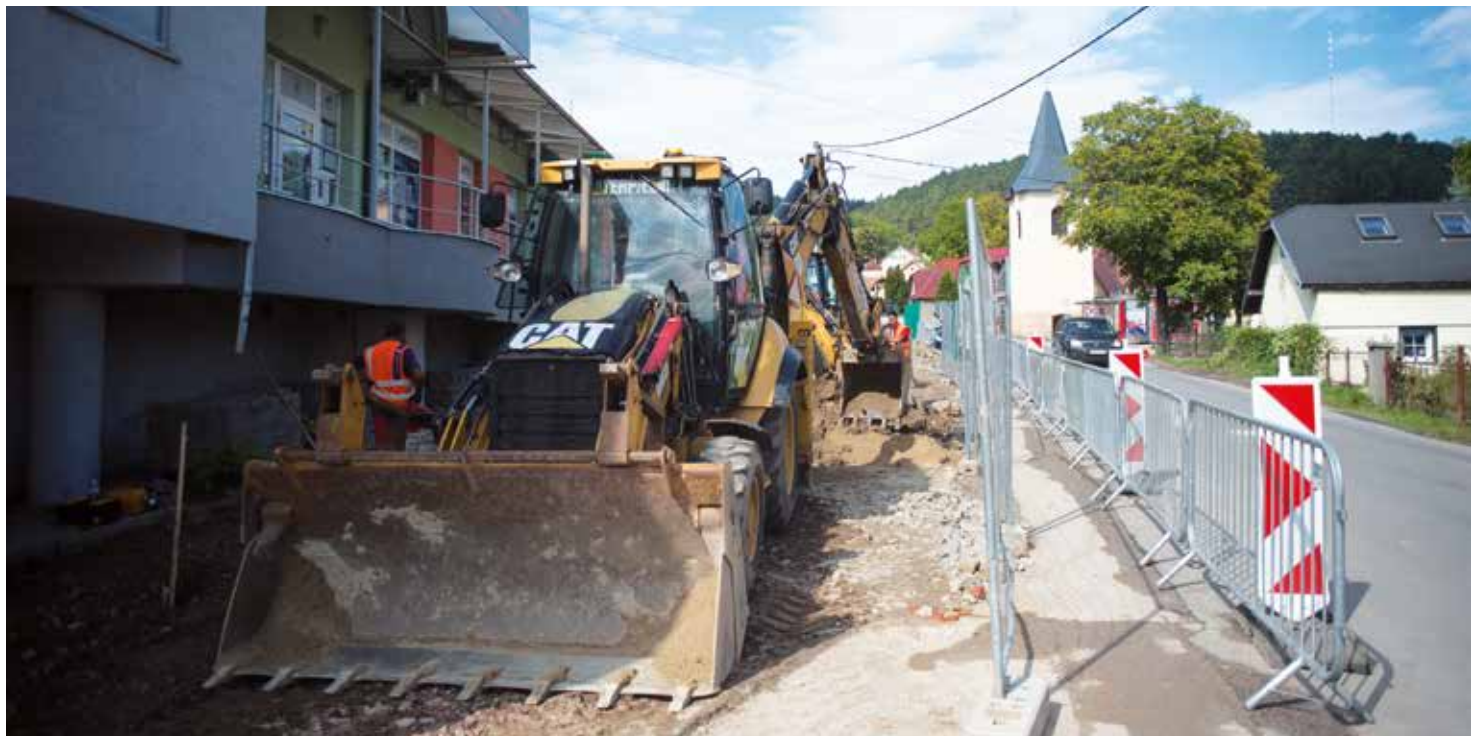
Na Povstaleckej ulici v Podlaviciach sú práce v plnom prúde
