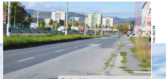
Zoolenská cesta pred opravou a po nej
