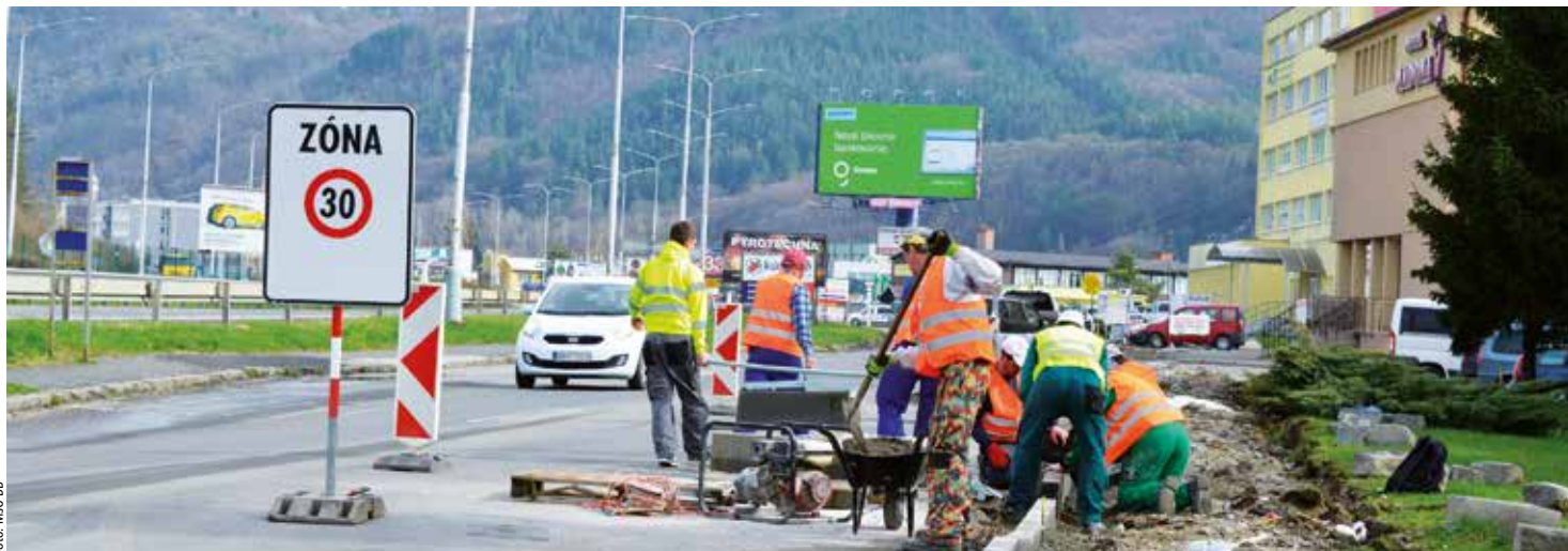
Začalo sa pri predajni AAA auto a opravuje sa po úsekoch
