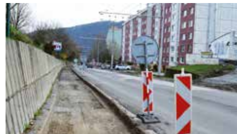
Začínajúce opravy chodníkov na Poľnej ulici
