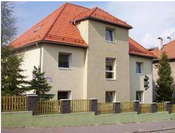
Obr. 1 Budova prevádzky Na Uhlisku 1
