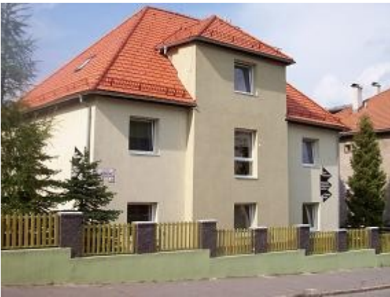
Obr. 1 Budova prevádzky Na Uhlisku 1
