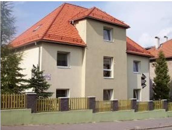
Obr. 1 Budova prevádzky Na Uhlisku 1
