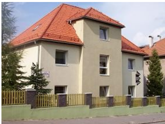
Obr. 1 Budova prevádzky Na Uhlisku 1
